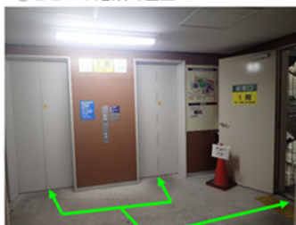
④ELVが階段で屋上へ
