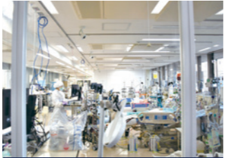
6月17日より稼働した「パンデミック病棟（陽性重症病棟）」
